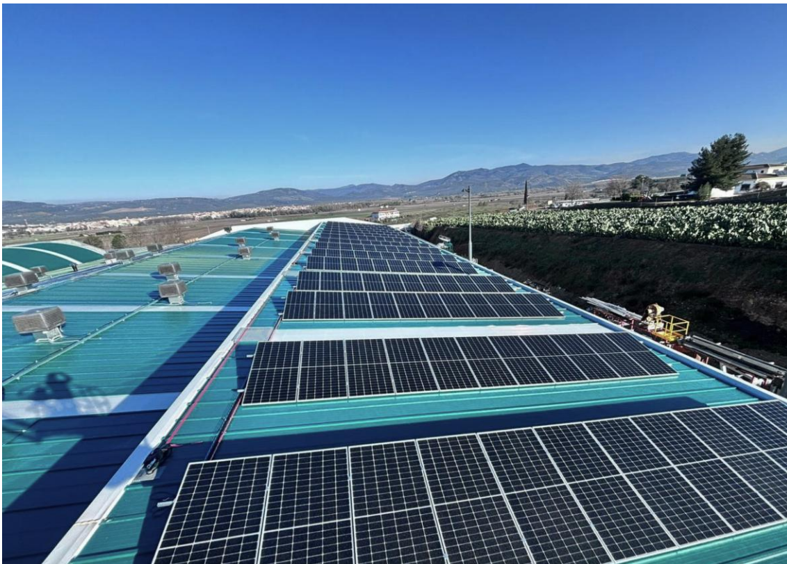
Foto: Proceso de instalación en cubierta en Asigran
