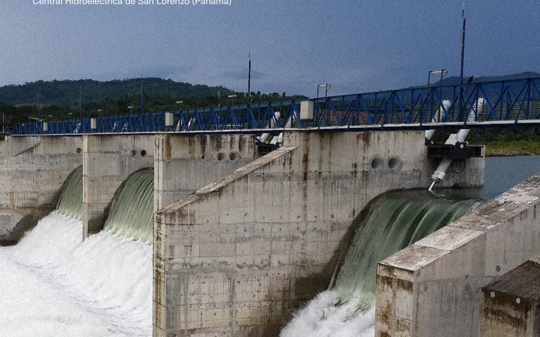
Central Hidroeléctrica de San Lorenzo (Panamá)
