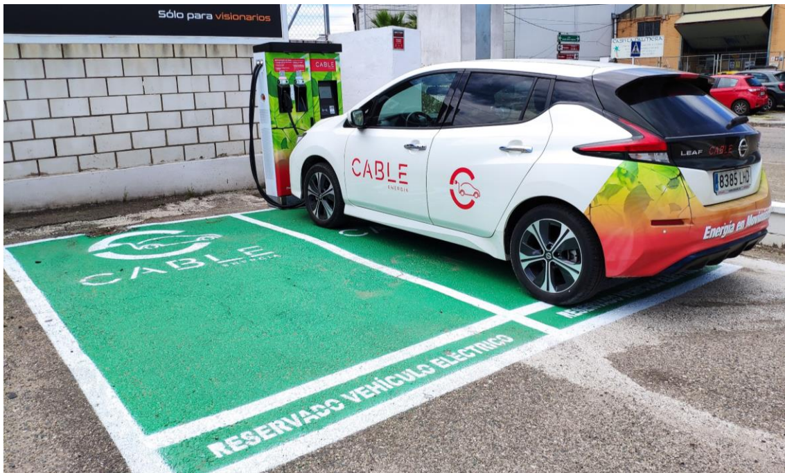
Punto de carga eléctrico de Cable Energía
